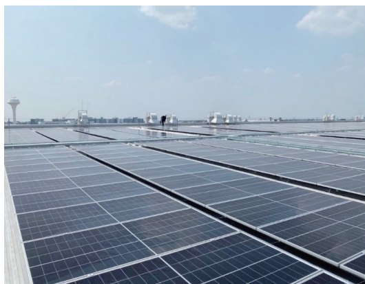
タイ工場での太陽光パネルの設置
