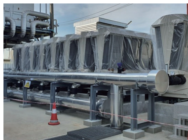
省エネボイラーの導入
