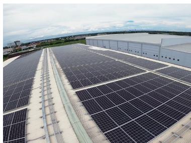
セブ工場での太陽光パネルの設置
