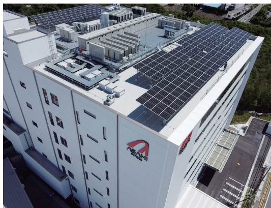
グローバル本社・R&Dセンター研究開発新棟「ANNEX棟」での太陽光パネルの設置
